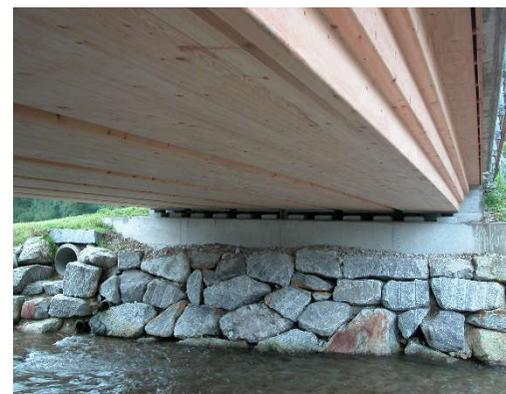
Infolge der Höchsthochwasserkote mit dem erforderlichen Freibord und der Strassennivelette, welche aus verkehrstechnischen Gründen möglichst tief gehalten werden sollte, bestand die Herausforderung darin, eine Brücke mit minimaler Höhe zu entwickeln.
