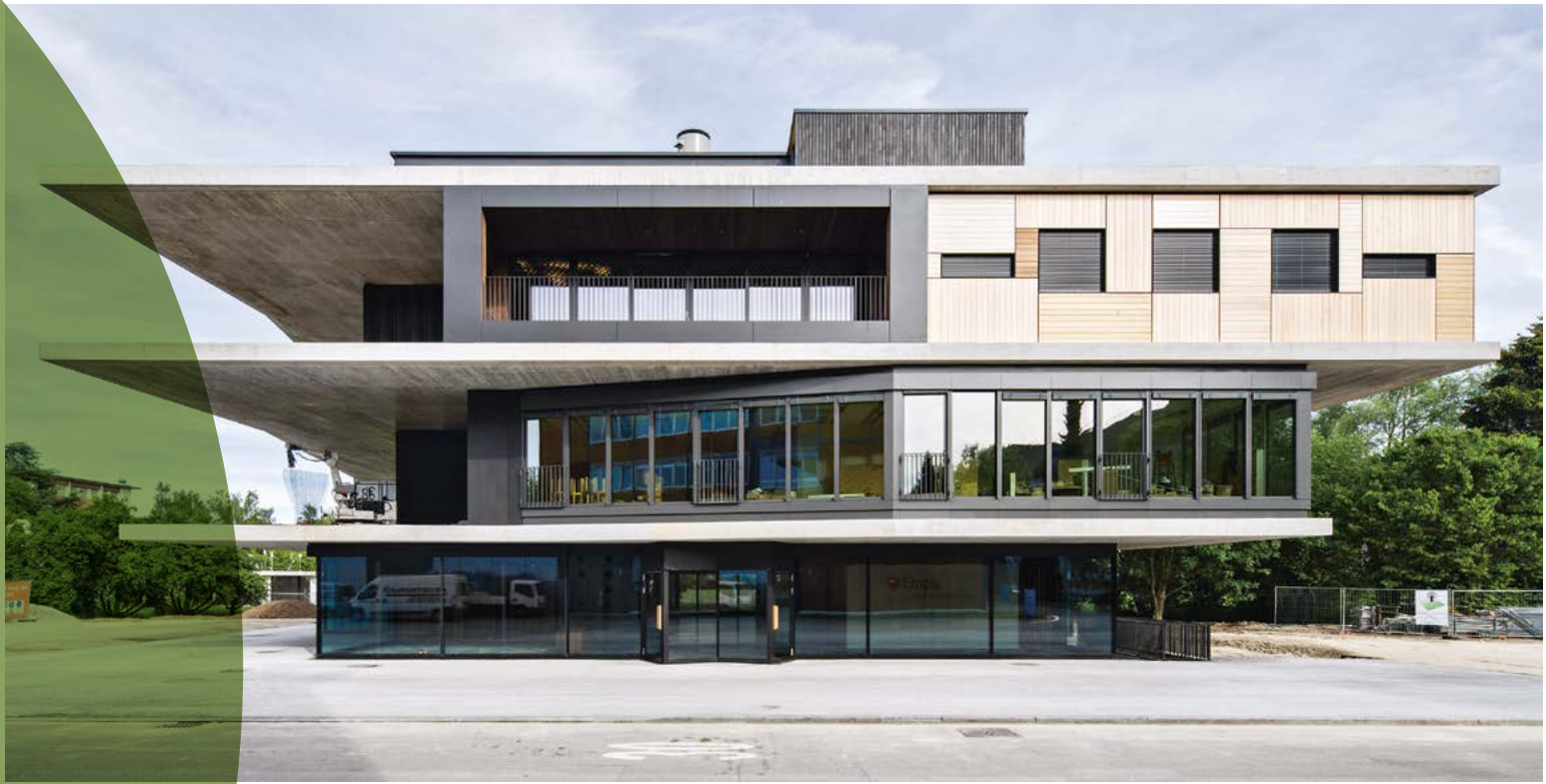
1_ Wie ein gestapeltes Quartier: In der permanenten Tragstruktur sind auswechselbare Forschungseinheiten untergebracht. (Fotos: Roman Keller)
