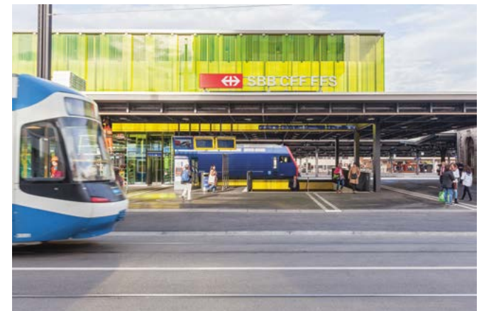
2_ Die Glasbaldachine wirken als weithin sichtbare Landmarken.
